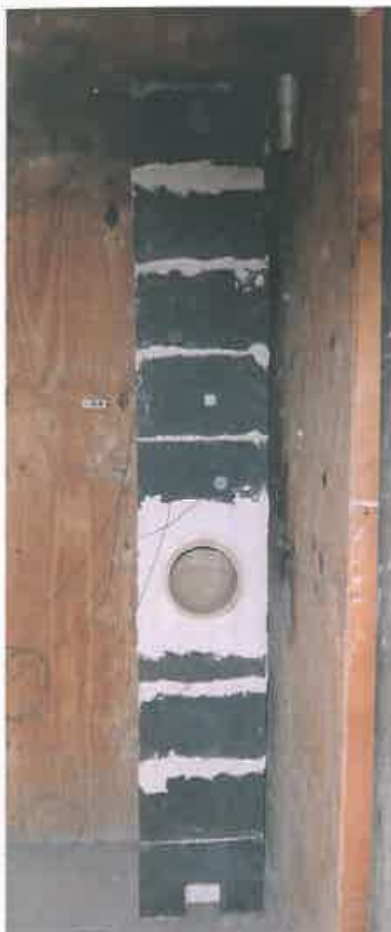
Vzorek komínu v rohové dřevěné konstrukci pod prvním stropem
