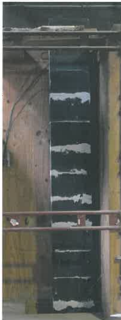
Vzorek komínu v rohové dřevěné konstrukci mezi stropy
