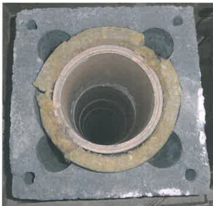
Uspořádání komínového systému
